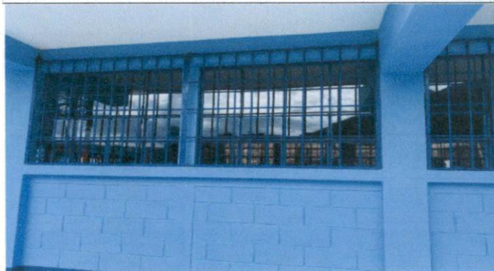
Foto 2: Fabricación de instalacion de balcones de hierro en ventana
