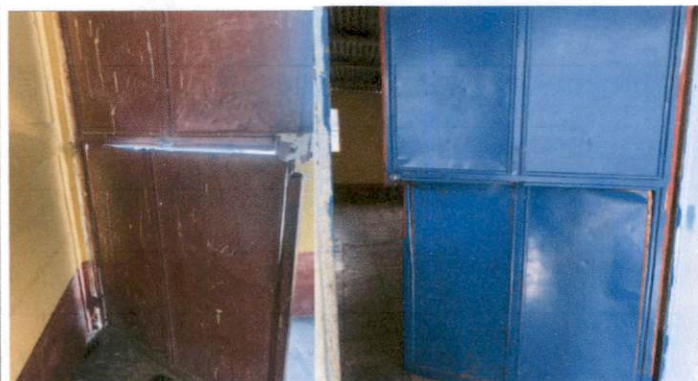
Foto 3: Mantenimiento a estructura (lijado, cambio de tubo , cepillado, sujeciones, aplicacion de pintura)
