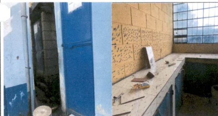
Foto 5: Sustrucción de Azulejo
