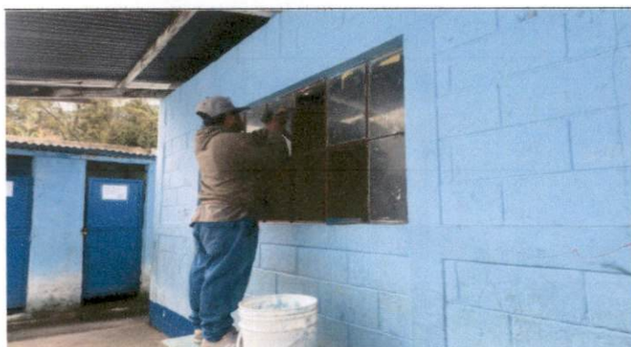
Foto 4: Sustrucción de vidrios
