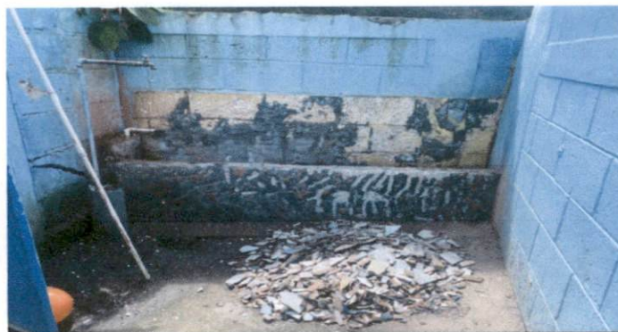
Foto 6: Sustrucción de mingitorio
